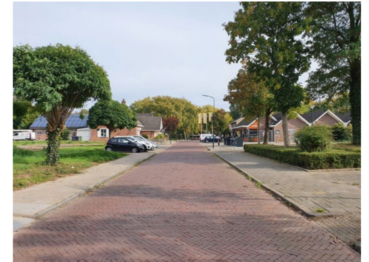
Locatie 3 - Straatprofiel richting Coop
