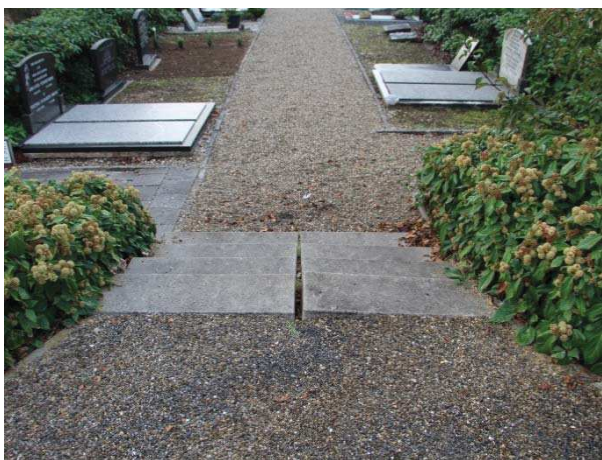
De trap begint te verzakken, dit moet hersteld worden. De zichtlijn op het water is niet mogelijk door de aanwezige begroeiing.
