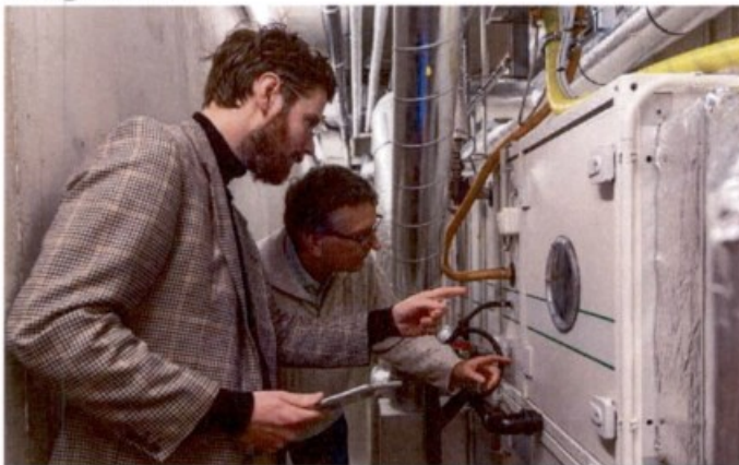
Foto Jikke Fotografie & Vormgeving: Inspectie bij de installaties van de depots
