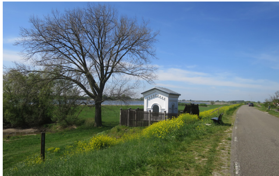
2 | Monumentaal peilschaalhuisje aan de dijk
