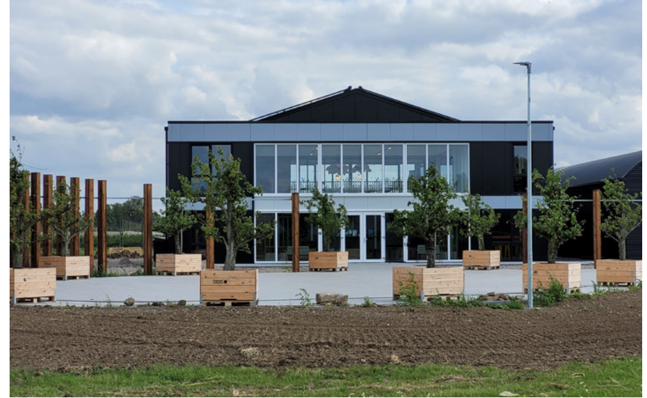
4 | Hoofdgebouw met atrium
