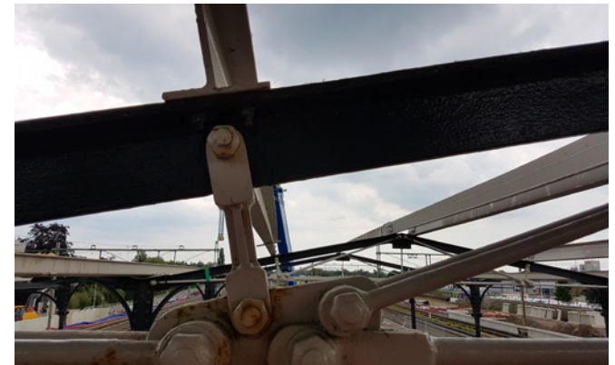
6+7 | Ontmanteling en herstel overkapping middenperron
