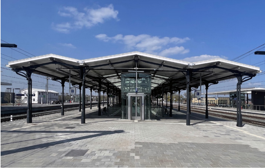
4+5 | Gerealiseerde aansluiting nieuwe onderdoorgang op bestaand middenperron
