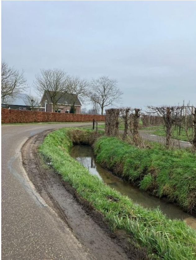
Smalle wegen leiden tot bermproblemen
