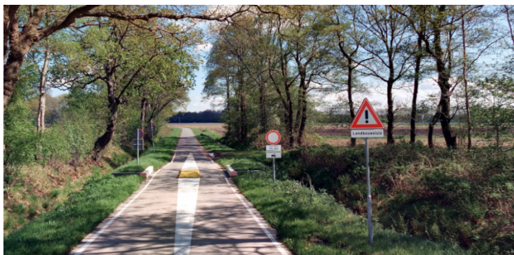
Figuur 2.5: Voorbeeld van een landbouwsluis op de Onlandweg, Tynaarlo
