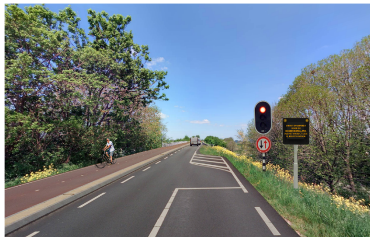
Figuur 4.3: Impressie gekoppelde doseerinstallatie nabij viaduct A15
