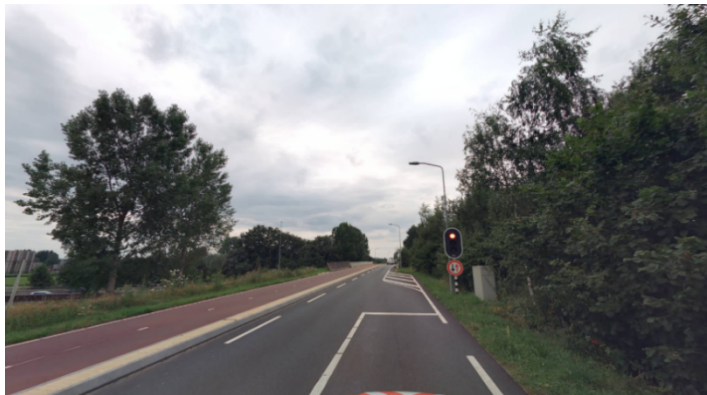
Figuur 2.7: Voorbeeld van een doseerinstallatie op de Maarderbuurtweg tussen Veenendaal en Ede
