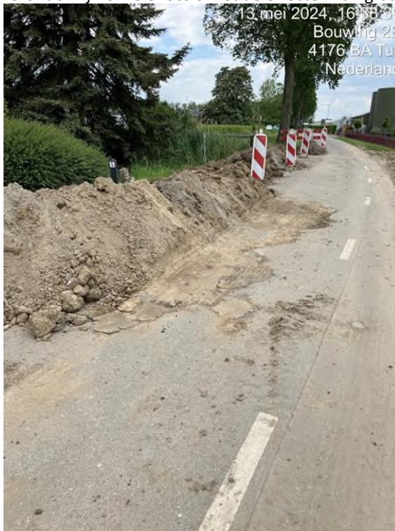
Figuur 14: Nutswerkzaamheden in een asfaltweg
