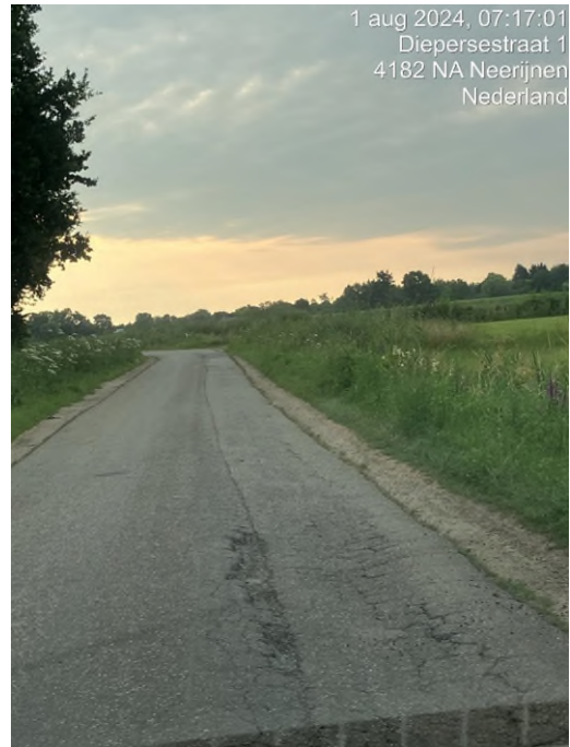
Figuur 13: Natte/ Droogte problematiek leidt tot ongelijke zetting in de weg en gevaarlijke spoorvorming.
