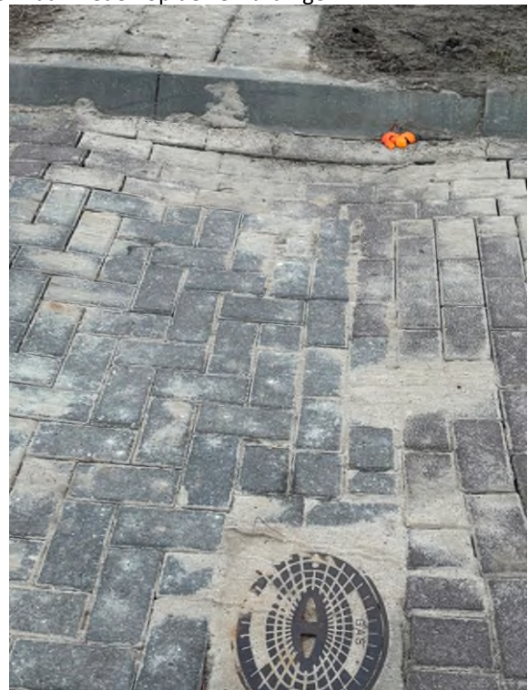
Figuur 15: Nazakken van bestrating na graafwerkzaamheden
