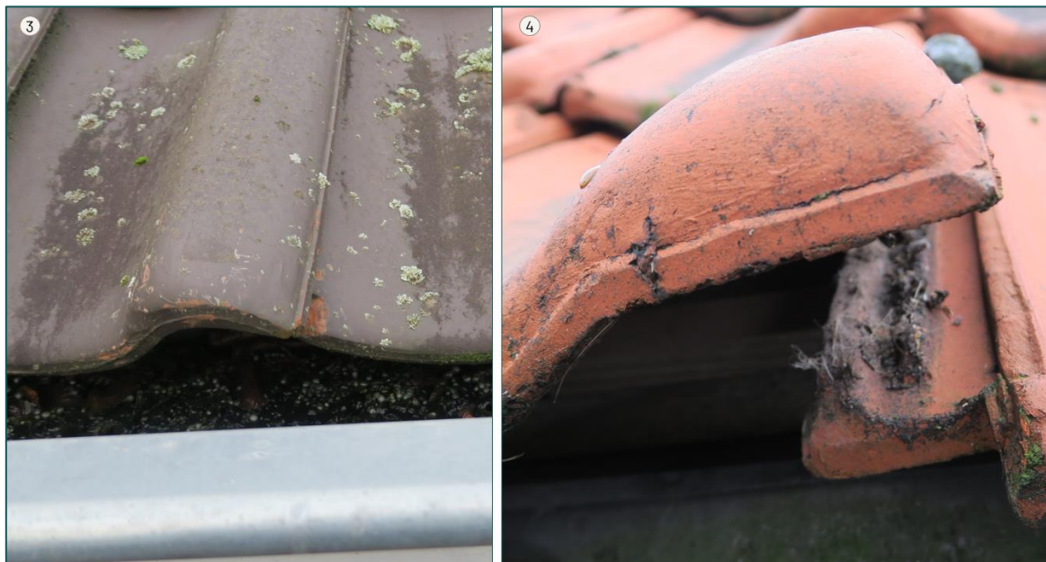
Figuur 3.3 Links: openingen onder de onderste rij dakpannen kunnen de huismus via de dakgoot toegang geven tot mogelijke nestlocaties in de bedrijfswoning (3). Rechts: de onderste rij dakpannen van de schuur (4) sluit nauw aan op de dakgoot. Onder de dakpannen bevindt zich opstaande rand waardoor er te weinig ruimte is voor betreding van de huismus.
