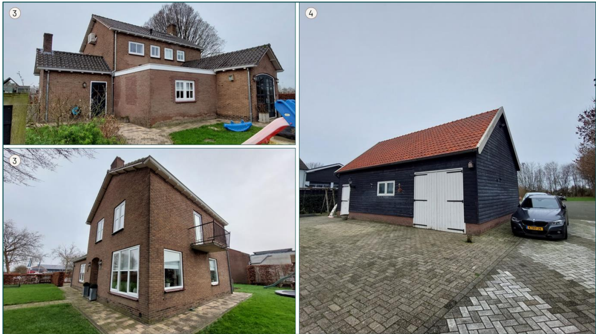
Figuur 1.4 Op de planlocatie is men tevens voornemens om de bedrijfswoning (3) en een schuur (4) te slopen.
