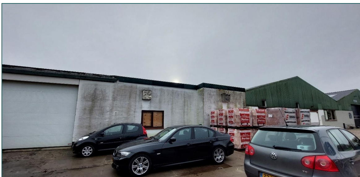
Figuur 2 Een deel van de loods aan de Heuvelstraat 7(2).
