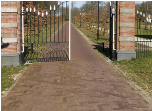
verharde toegangsweg en parkeerplaatsen
