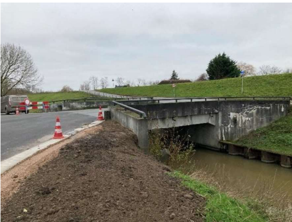
001 – Sonsbrug over de Culemborgse Vliet
