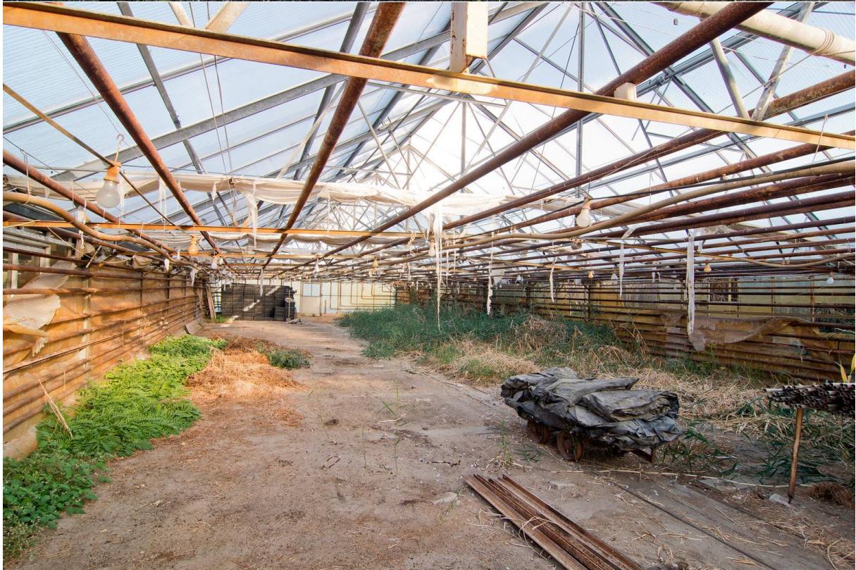
Afbeelding 7: Foto's te slopen kassencomplex
