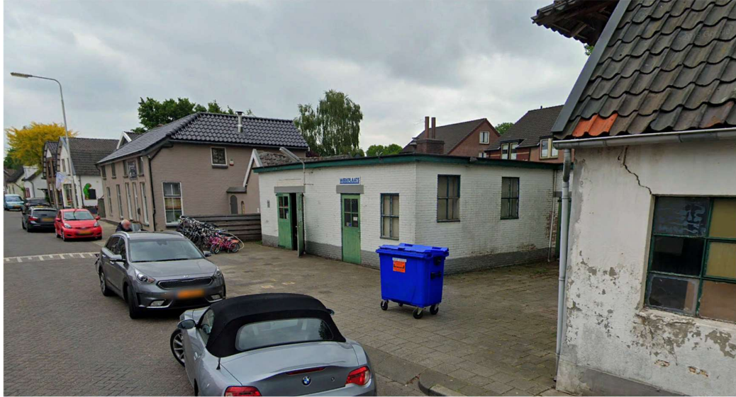
Fig. 2.4 Te slopen bedrijfsbebouwing (werkplaats)
