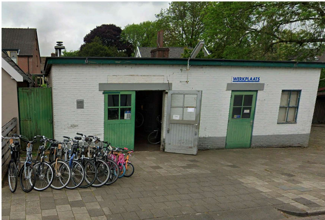
Fig. 2.5 Te slopen bedrijfsbebouwing (werkplaats)
