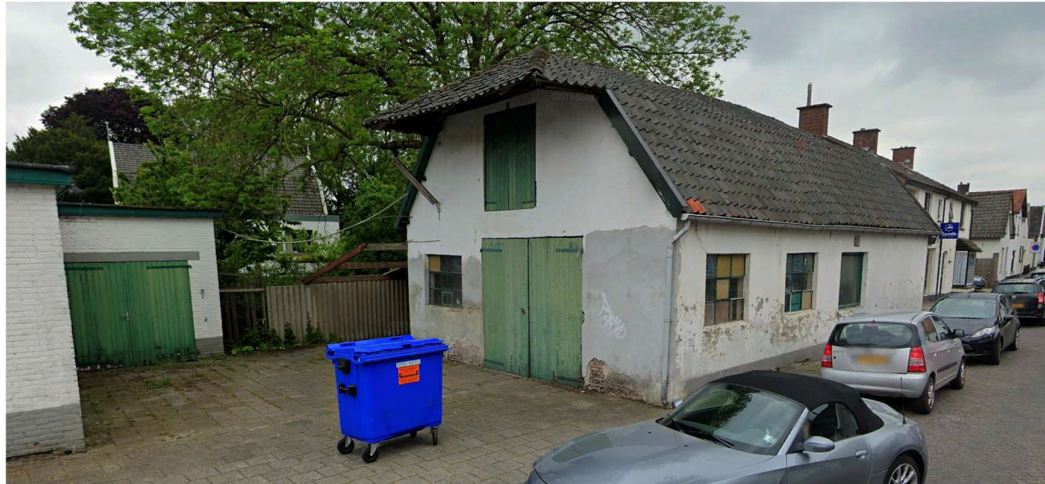
Fig. 2.2 Te slopen woonhuis (oostzijde)
