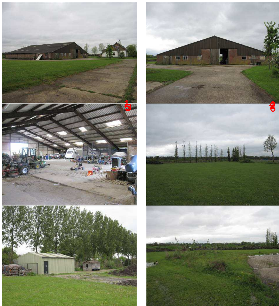
Figuur 3: Impressie plangebied. 1: Schuur/loods en woning; 2: vooraanzicht schuur/loods; 3: binnenkant schuur/loods; 4: uitzicht in zuidelijke richting; 5: kleine loods en tuinhuisje; 6: ruigte (Croonen Adviseurs, 2010)
