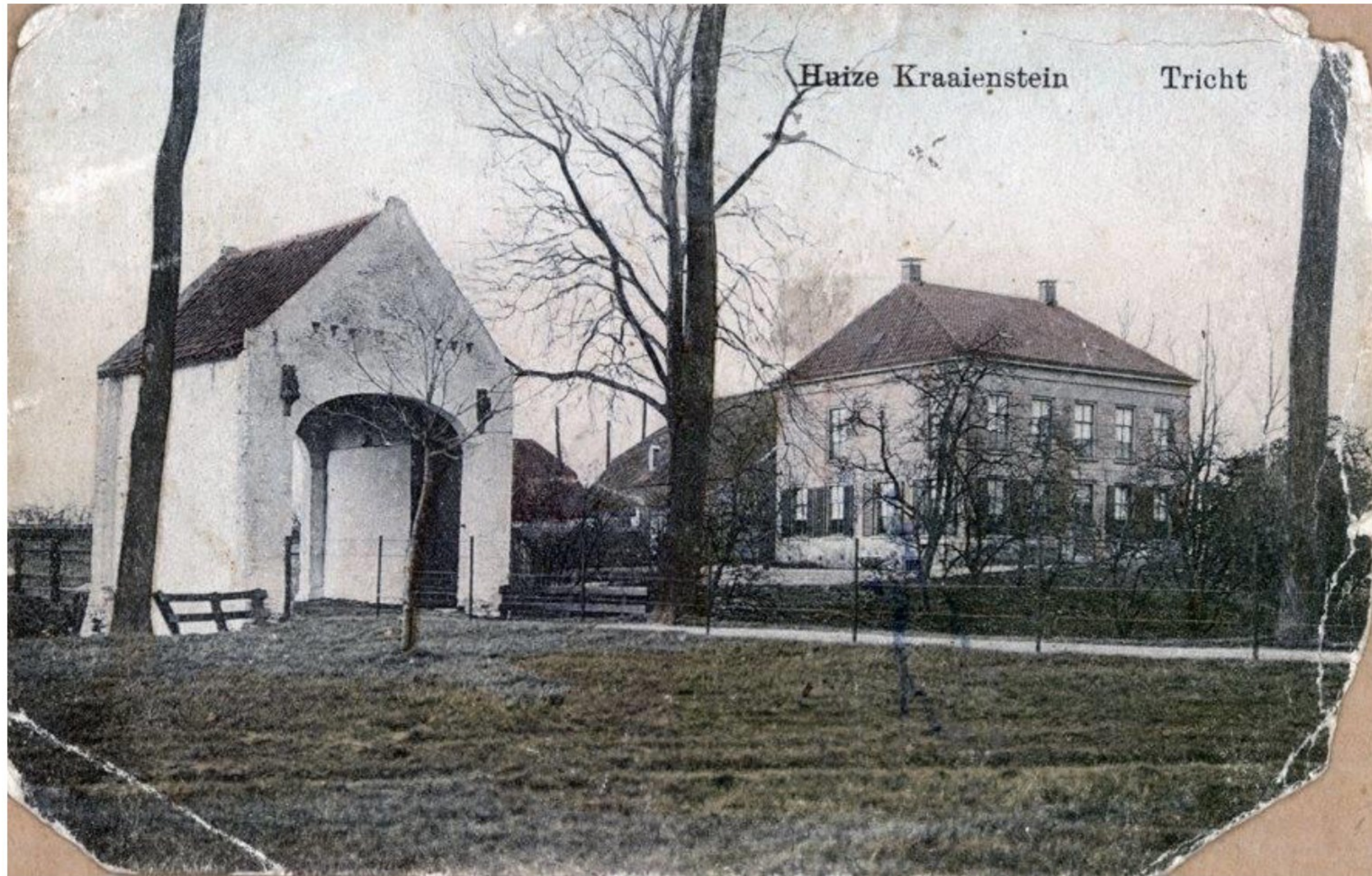
Omstreeks 1920. Poortgebouw zonder trapgevel, nog gestukt.
